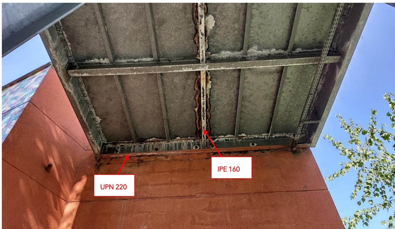
Tablier de la passerelle sud. Vue du dessous.
